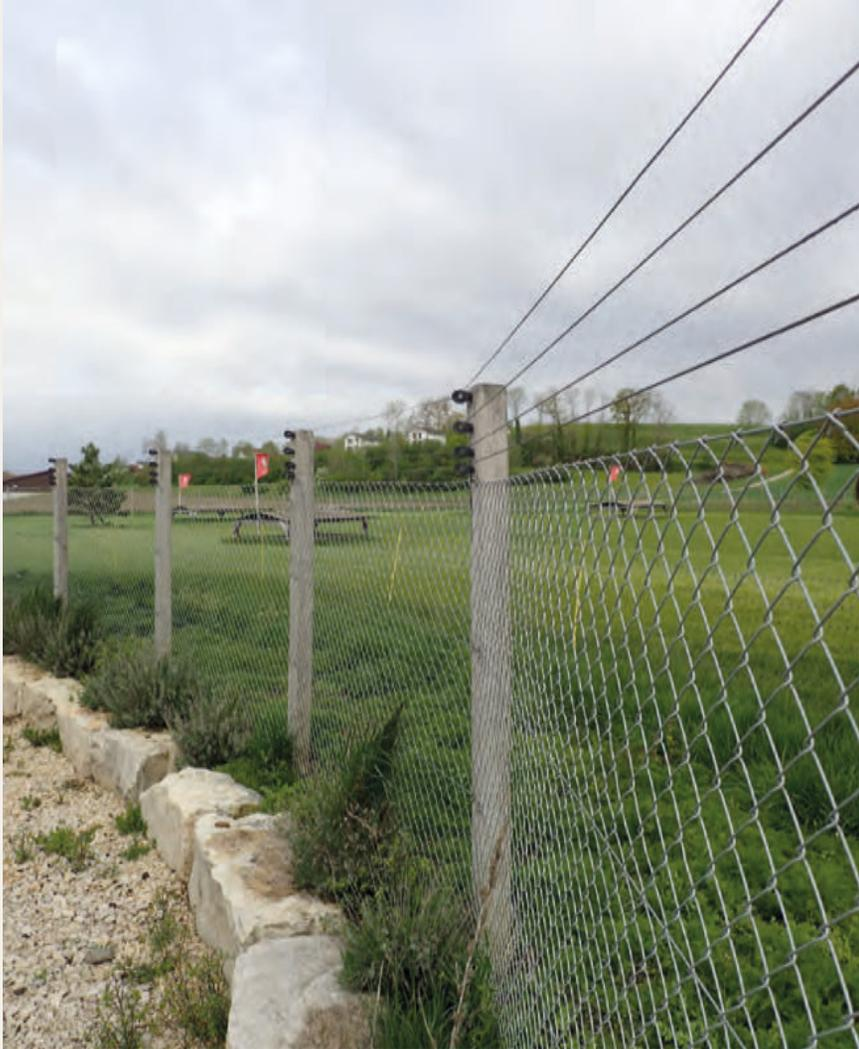
Abb. 90: Aufwendiger, aber sehr wirkungsvoller eingegrabener Festzaun mit Elektrodrähten gegen Landbeutegreifer
