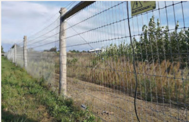
Abb. 113: Überkletterungs- und Untergrabungsschutz
