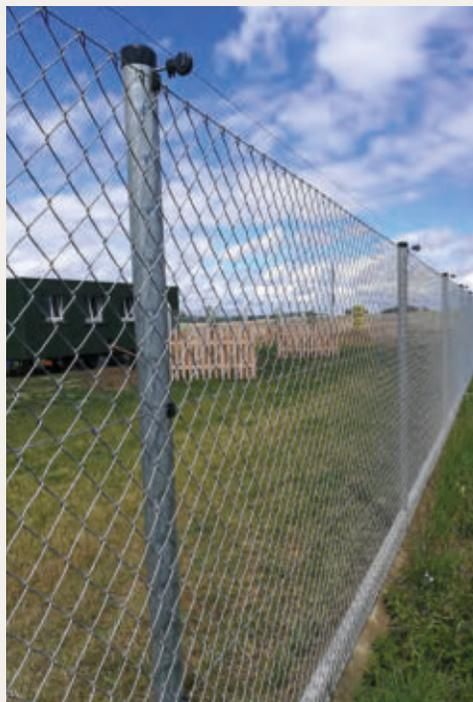
Abb. 115: Eingegrabener Maschendrahtzaun mit Überkletterungsschutz
