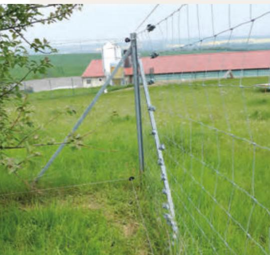
Abb. 93: Festzaun mit zwei Litzen. In geringer Höhe kann ein Fuchs oder Marder an den Zaun springen und leicht durch die großen Maschen schlüpfen.
