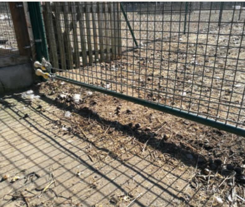
Abb. 120: Der Abstand zwischen Boden und Tor ist zu groß.
