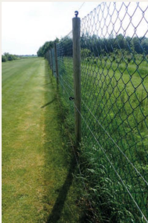
Abb. 114: Dreifache Absicherung gegen Untergraben und Überklettern. Die unteren Litzen müssen von Bewuchs freigehalten werden.
