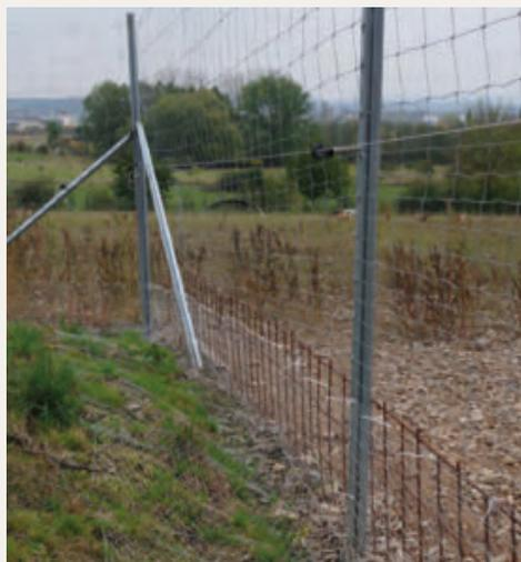
Abb. 119: Untergrabungsschutz durch ausgelegtes Zaunmaterial am Boden
